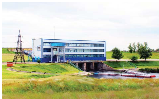
Рис. 9. Насосная станция подает воду в закрытую оросительную сеть
