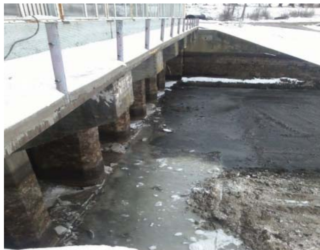
Рис. 4. Место забора воды всасывающими трубопроводами перед очисткой аванкамеры и подготовкой к поливному сезону
