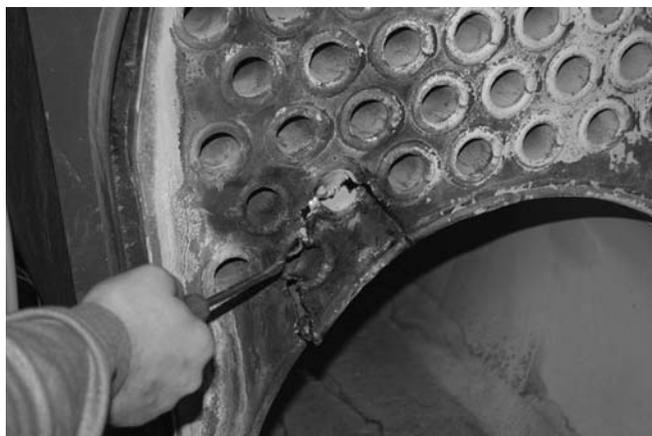
Рис. 1. Фрагментарная резка котла
